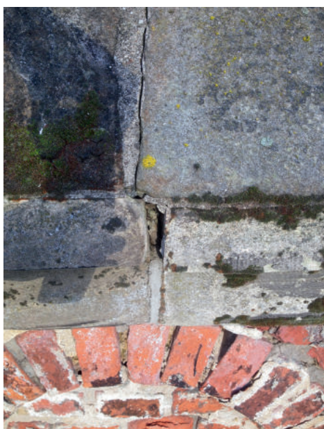
ABB. 5 Detail Fugenbild mit Abriss von der Steinflanke und teilweise Verlust des Fugenmörtels. Darunter sichtbar Auswitterungen des Fugenmörtels im Mauerwerk des Traufbereiches (2014)
